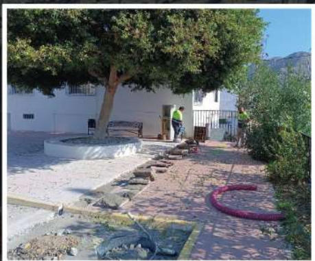
Obra instalación camión Cajamar
